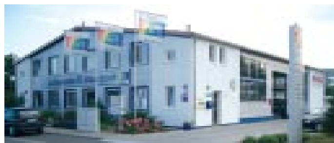
Das Firmengebäude in den Pfüßenäckern in Erlenbach
